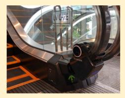
1回の紫外線照射で90%、10回以上の照射で99%の新型コロナウイルスを不活性化させる 除菌器を設置しています
