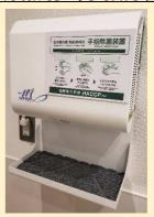
お手洗い・パントリーには、紫外線照射によって、 手指を乾かしながら除菌できる、熱風・紫外線 照射式の除菌器を設置しています
